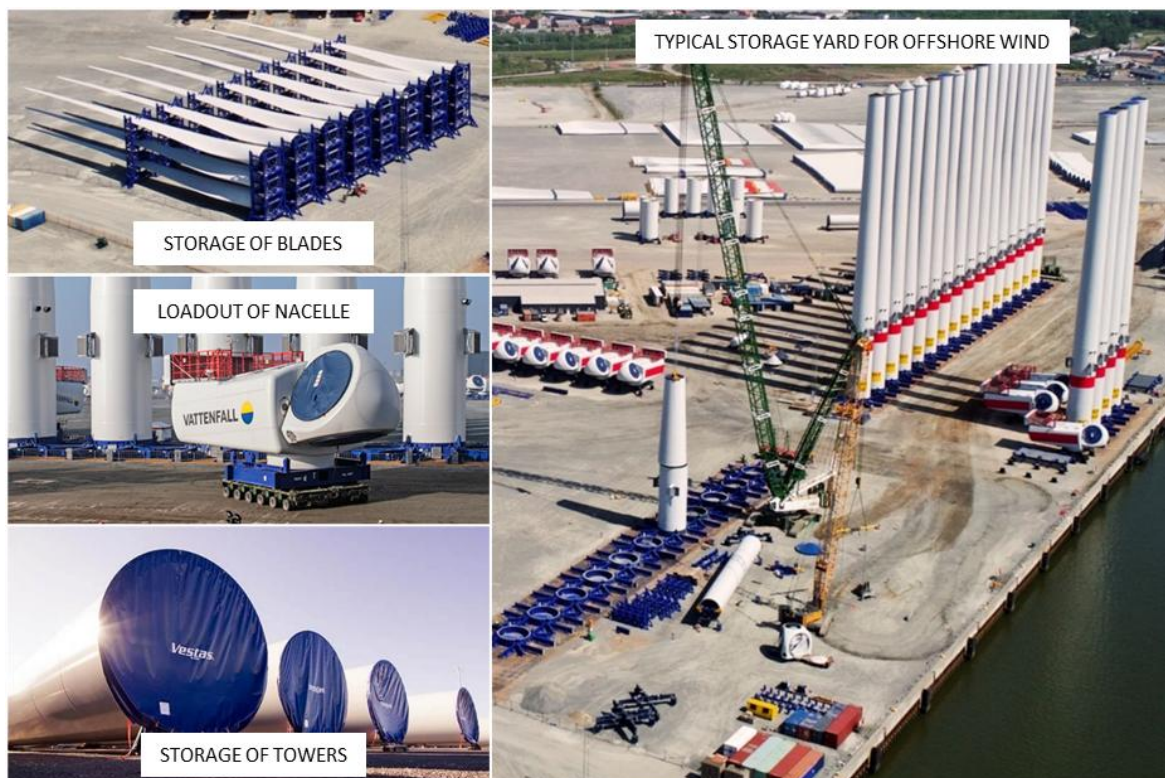
Figura 2-4 Operações de armazenamento de pás, nacelle e torre
